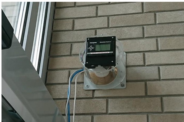
Óramű és 2058 vezérlő a fal belső oldalán
