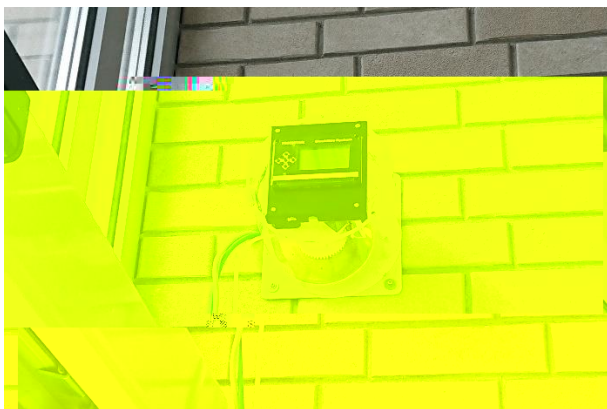
Óramű és 2058 vezérlő a fal belső oldalán
